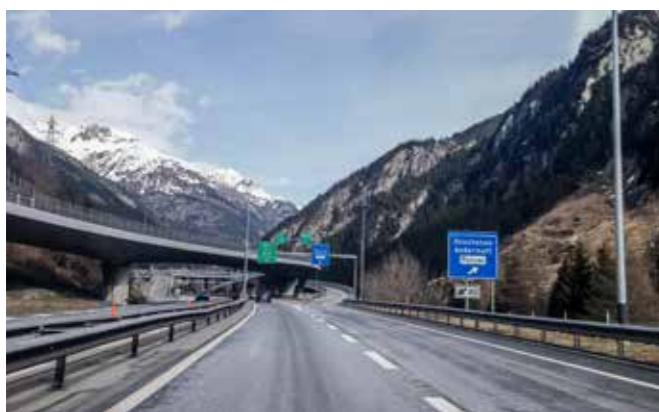
Na putovanju do Berna prošli smo kroz poznati tunel Gotthard Road Tunnel koji je dug 16,9 kilometara.
